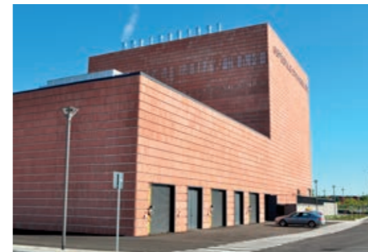
Krankenhaus, Vimercate, Italien Installierte elektrische Leistung: 6 MW Anzahl der Blockheizkraftwerke: 3 Baujahr: 2009
