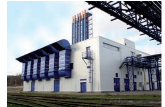
Industriebetrieb, Svit, Slowakei Installierte elektrische Leistung: 12 MW Anzahl der Blockheizkraftwerke: 6 Baujahr: 2010
