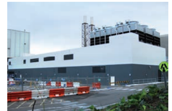
Flughafen, Sydney, Australien Installierte elektrische Leistung: 12 MW Anzahl der Blockheizkraftwerke: 4 Baujahr: 2012
