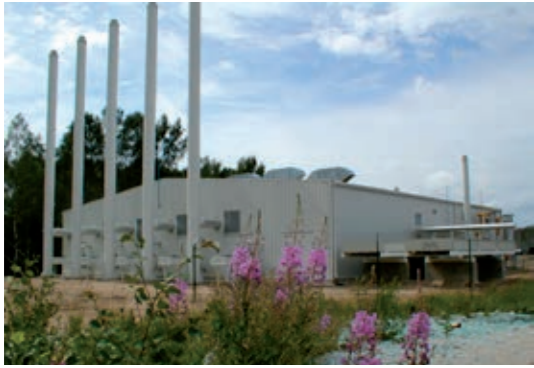
Deponie Getlini, Riga, Lettland Installierte elektrische Leistung: 5,2 MW Anzahl der Blockheizkraftwerke: 5 Baujahr: 2001
