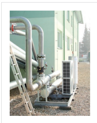
Biogasanlage Vysoké Mýto - GTS 400
